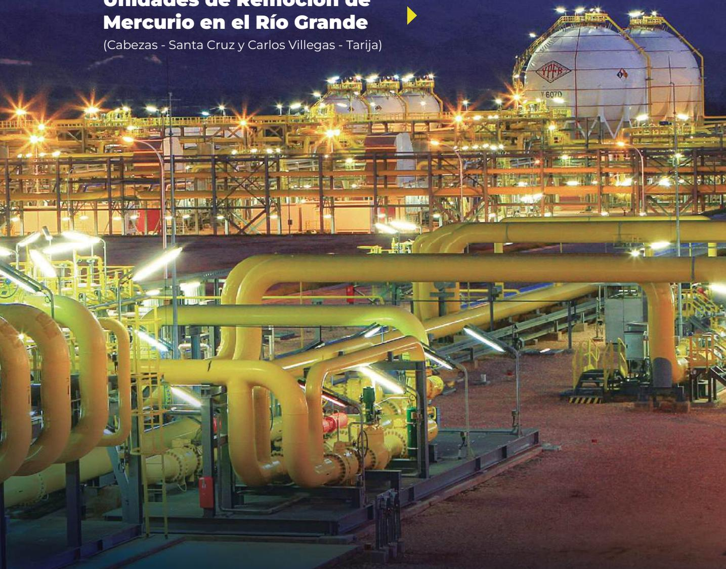
Su instalación **permitirá reducir la concentración de mercurio hasta límites aceptables en el gas natural** antes de que este ingrese a la etapa de deshidratación. Esto disminuirá el riesgo de daño en los equipos debido a la presencia de este elemento no deseado en las corrientes de alimentación a las Plantas de Separación de Líquidos de Río Grande y Carlos Villegas.
